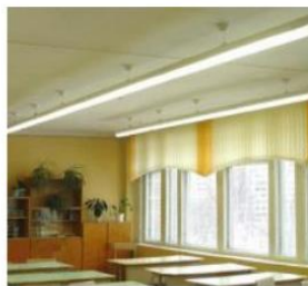
Работа освещения в пасмурную погоду и темное время суток Светильники K22-135У (Т5 1x35Вт) 336 Вт на класс 8,5х6м с датчиками освещенности K2110 или 6,5Вт/кв.м
